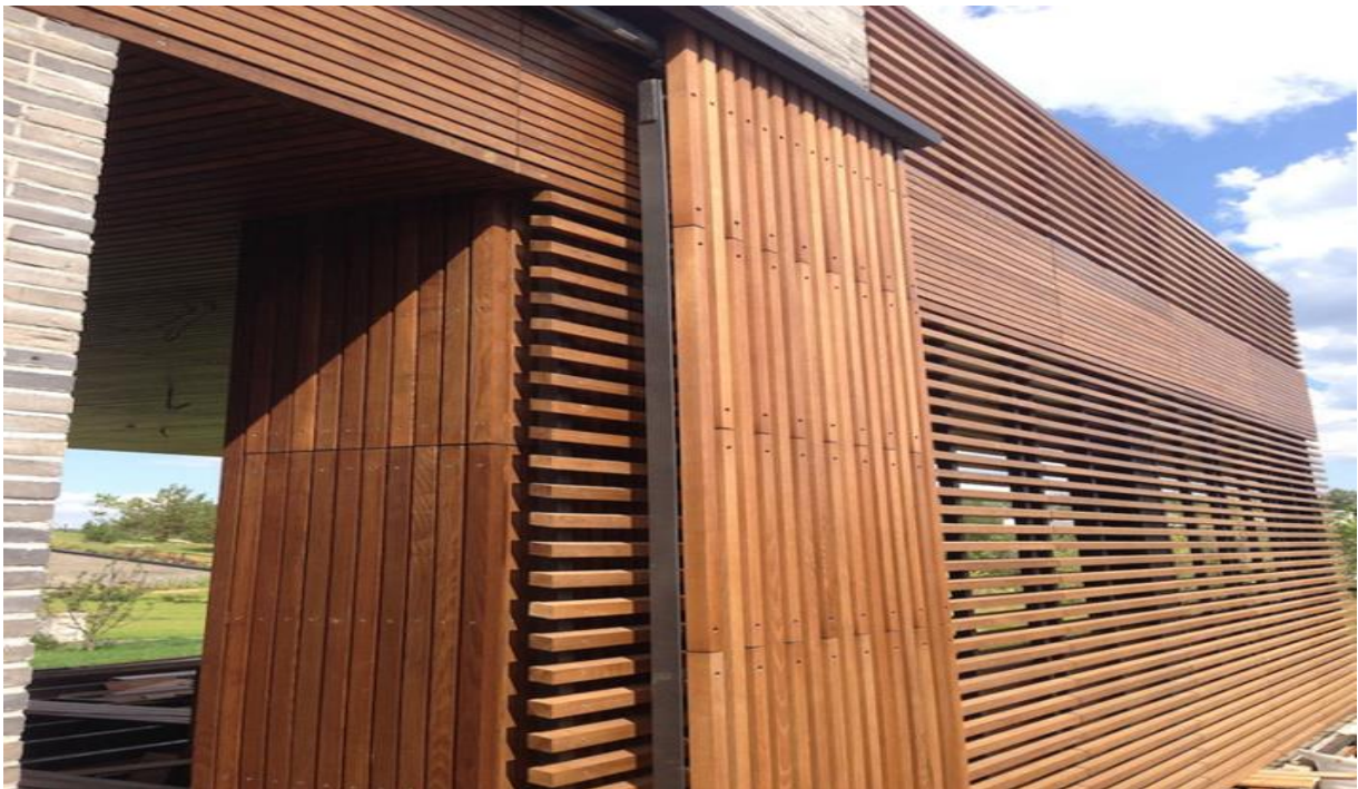
Foto 3, Construcciones al exterior con madera termo modificada
